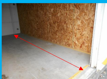
室内の奥行き 約5.4m
