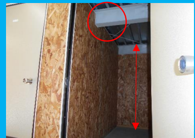
室内の高さ 約2.2m (構造上、鉄骨が出ている箇所があります)
