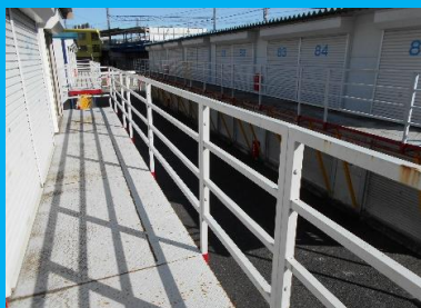
2階部分の共用通路
