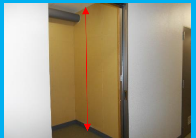
室内の高さ 約2.2m
