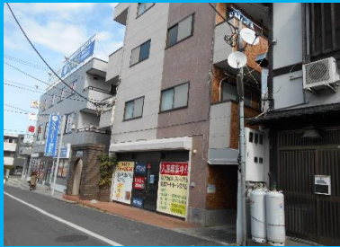
4階建てマンションの1階部分
