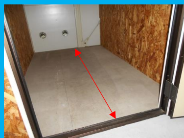
室内の奥行き 約2.1m
