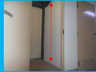
室内の高さ 約2.3m
