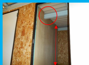
室内の高さ 約2.2m (構造上、鉄骨が出ている箇所があります)
