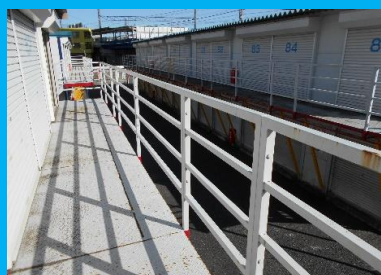
2階部分の共用通路
