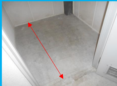
室内の奥行き 約1.8m
