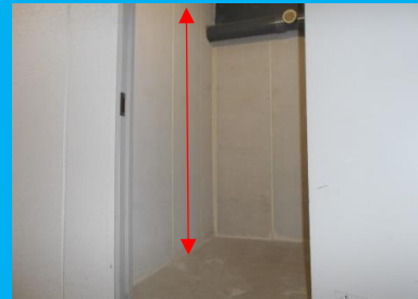
室内の高さ 約2.3m
