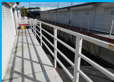
2階部分の共用通路
