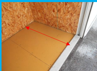
室内の奥行き 約1.3m
