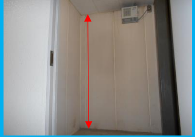
室内の高さ 約2.3m
