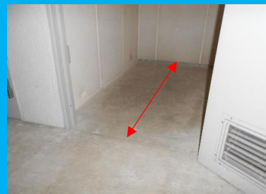
室内の奥行き 約1.8m
