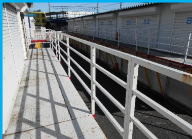
2階部分の共用通路
