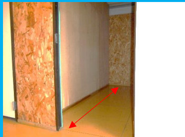
室内の奥行き 約2.15m
