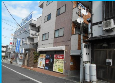
4階建てマンションの1階部分
