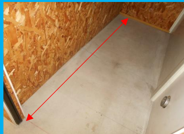
室内の奥行き 約2.15m
