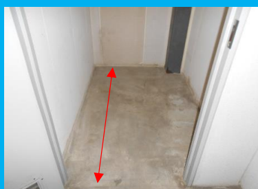
室内の奥行き 約1.8m
